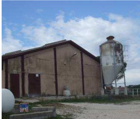
Fig. 5 – Silos di stoccaggio mangime
