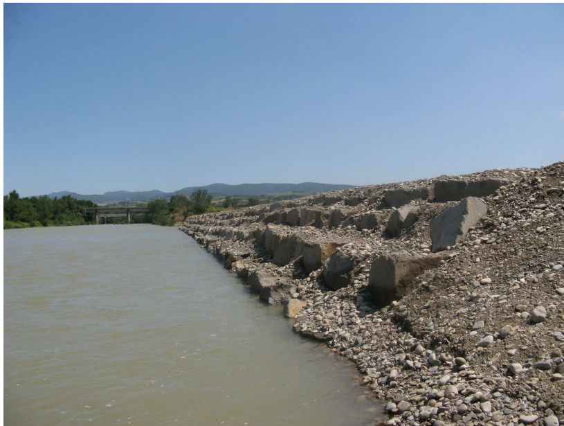
(consolidamento spondale fiume Tevere Loc. Attigliano)
