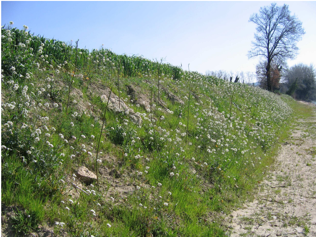
(Consolidamento spondale fiume Tevere Loc. Montecchio)
