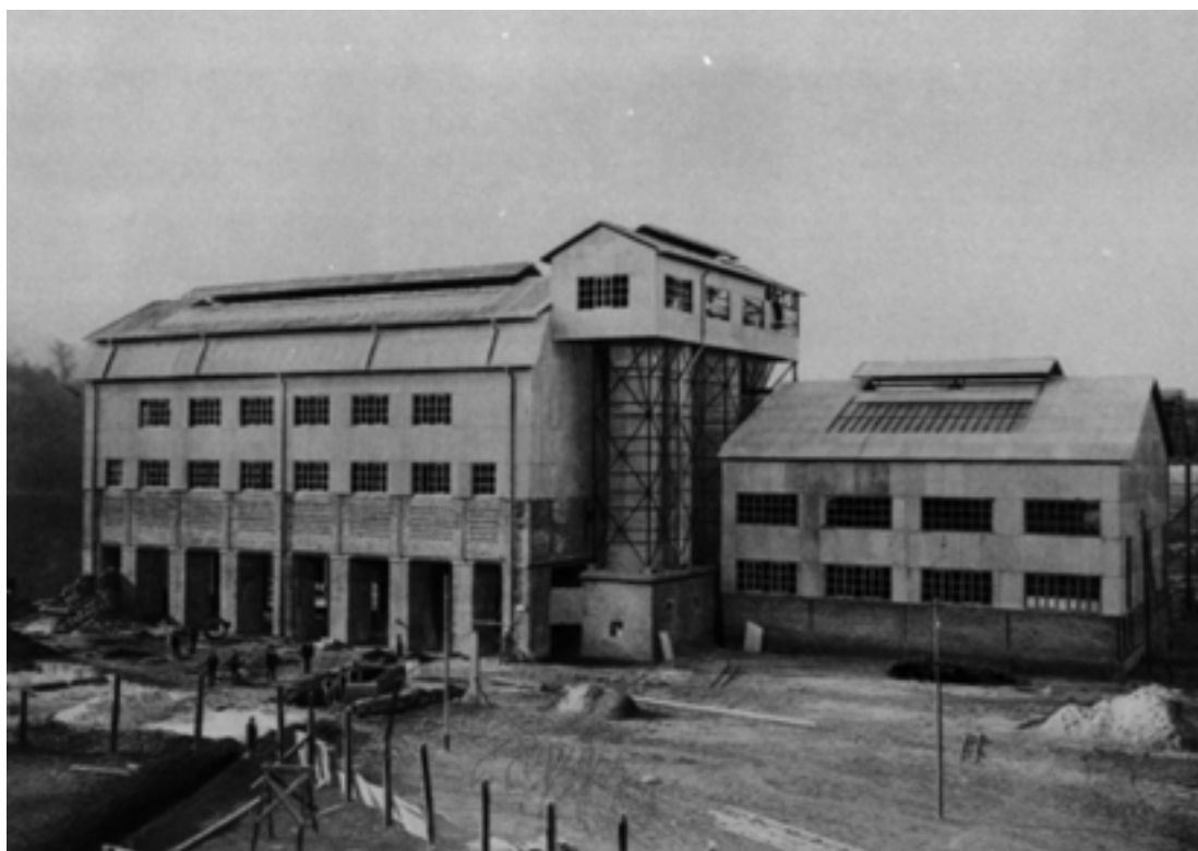
Il reparto per la fabbricazione dell'acido solforico (Terni Società per l'Industria e l'Elettricità. Anonima. Sede in Roma. 1884-1934, Genova 1934).
