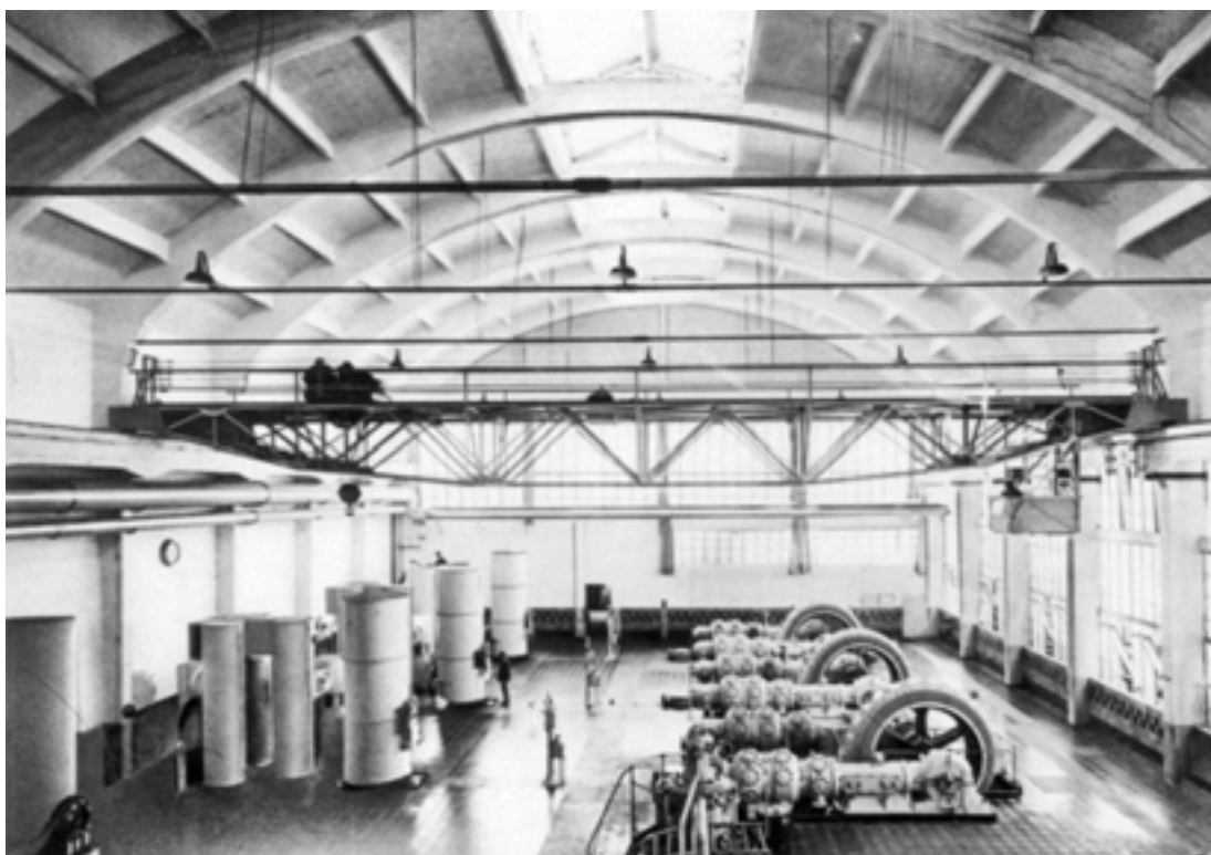
La sala Claude (Terni Società per l'Industria e l'Elettricità. Anonima. Sede in Roma. 1884-1934, Genova 1934). Nel 1960, la sala Claude viene ampliata sulla destra con l'aggiunta di un impianto per il frazionamento dell'aria. Nel suo complesso, ancora oggi il reparto conserva buona parte dei macchinari.
