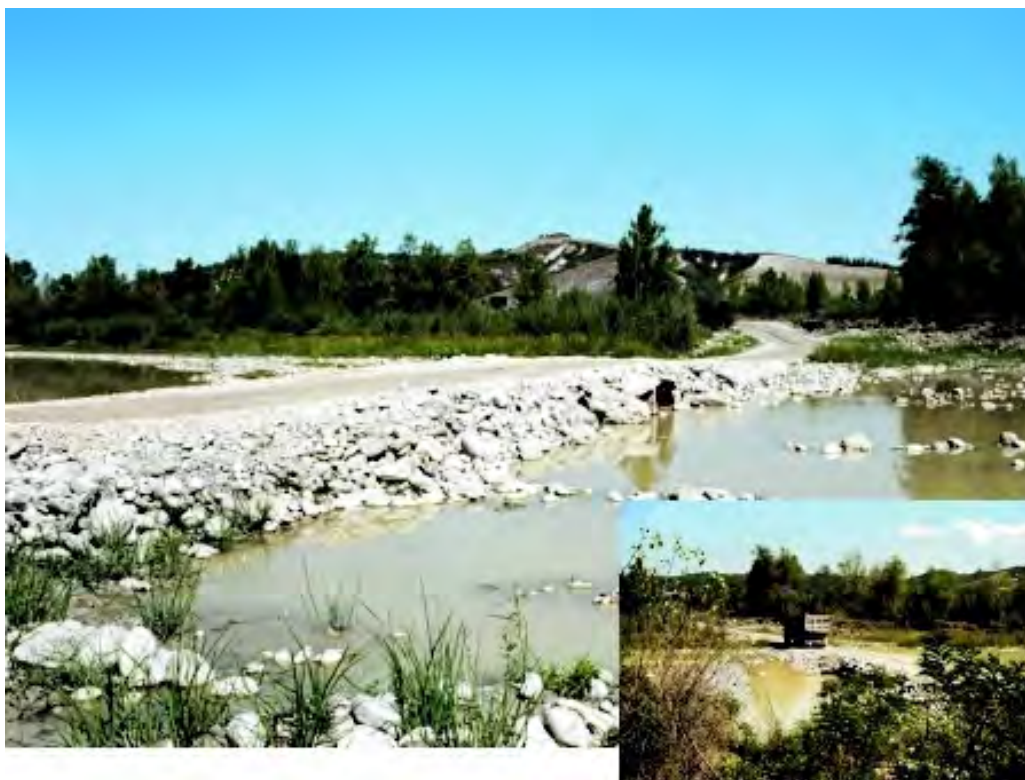
Fig. 55 - Guado in corrispondenza della progressiva 46,95 km AdA. La foto è stata scattata nel mese di settembre 2003.
