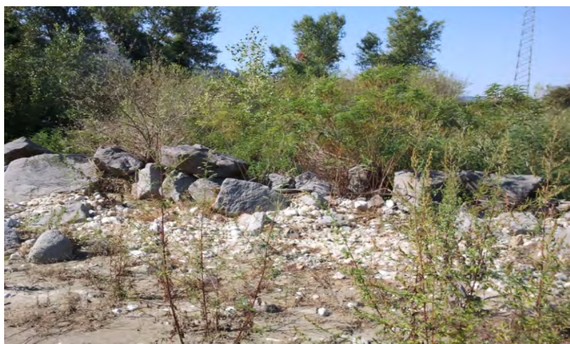
Fig. 65 - Scogliera in massi (OL 10). Ormai risulta inglobata in una barra laterale ghiaiosa.
