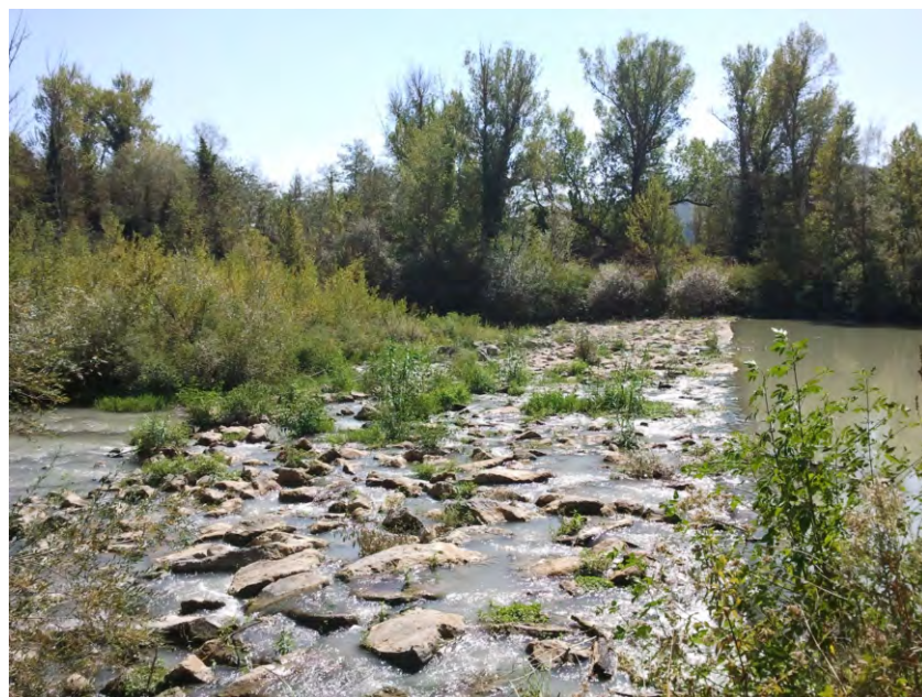
Fig. 66 - Traversa in massi e calcestruzzo (OT 7), vista dalla riva sinistra.
