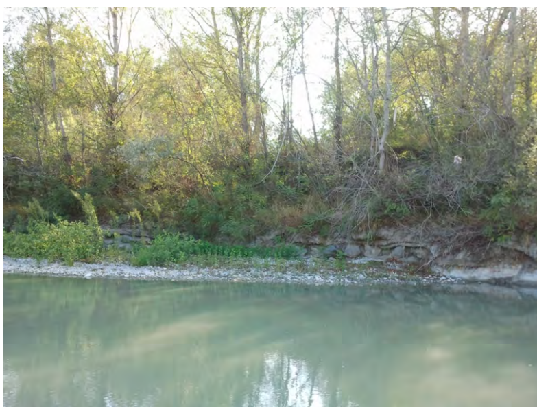
Fig. 63 - Scogliera in massi (OL 7), si presenta in buone condizioni e fortemente rivegetata anche con alberi ad alto fusto.
