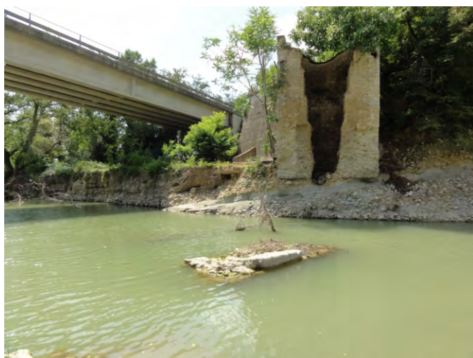
Fig. 41 - Spalla del vecchio ponte, appena a monte della Provinciale SP 48 (OT 1). La quota di fondo alveo al momento della realizzazione del ponte, e che corrisponde alla base della fondazione, è pari a 150 m s.l.m.
