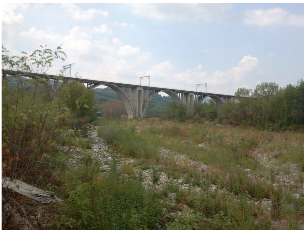
Fig. 46 - Ponte della linea ferroviaria Direttissima, visto da valle.
