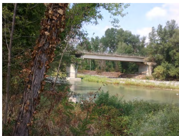
Fig. 44 - Ponte della provinciale n. 48 visto da valle.
