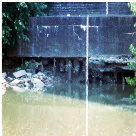
Fig. 11 - Lo stato delle opere che interferiscono con la dinamica dell'alveo è uno degli indizi più importanti sull'entità e la velocità dei processi di erosione in atto.
