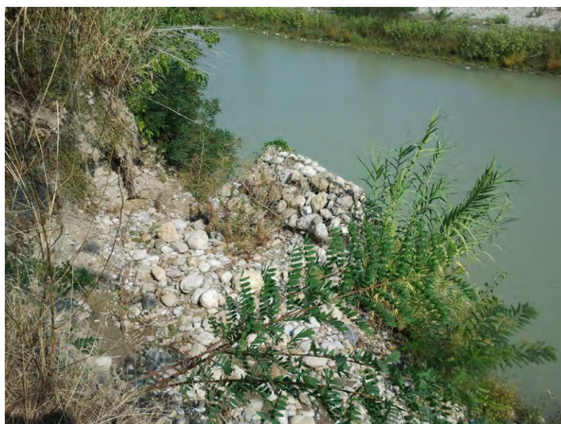
Fig. 57 - Pennello di non recente costruzione, franato in alveo.
