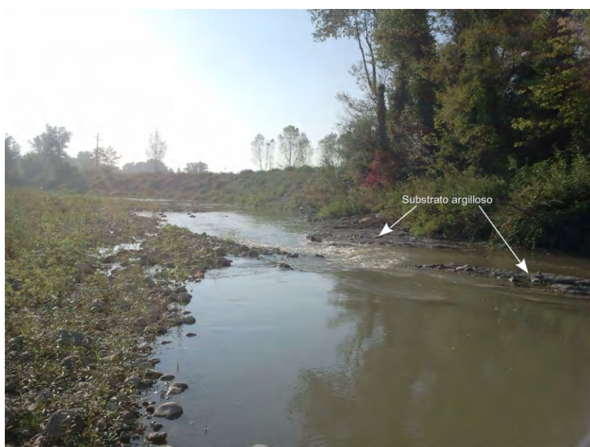
Fig. 61 - Affioramento del bedrock nel canale – progressiva 52,2 km AdA.
