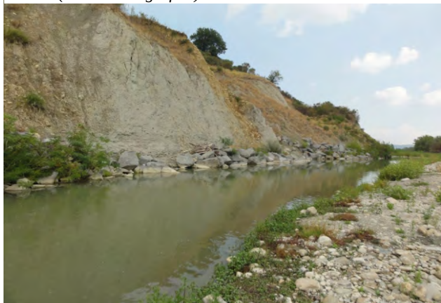
Fig. 50 - Scogliera in massi a difesa del versante in sinistra idrografica.
