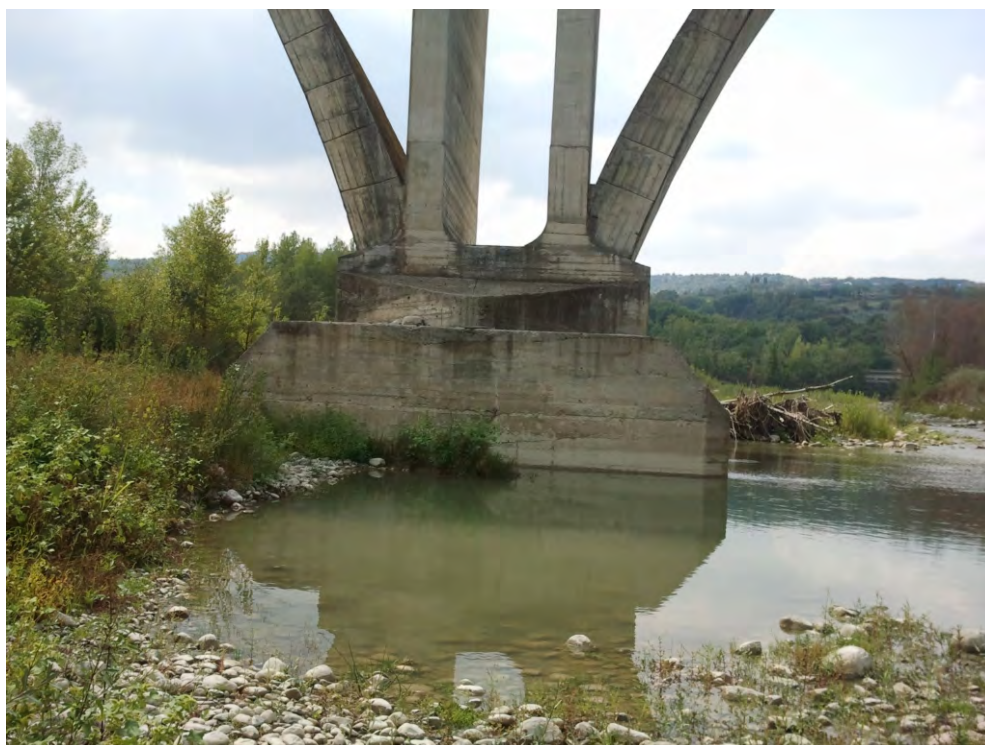
Fig. 45 - Ponte della linea ferroviaria Direttissima, pilone in alveo, visto da valle.
