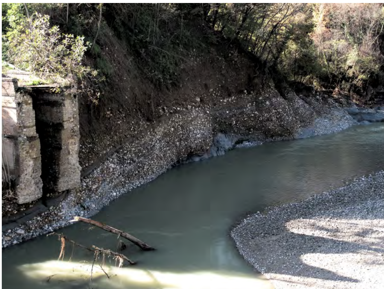
Fig. 34 - La foto mostra i sedimenti alluvionali del F. Paglia, affioranti in sezione lungo una delle profonde incisioni dell'alveo, in corrispondenza del ponte della SP 48, nei pressi di Alleron. Si nota 1) l'entità dell'approfondimento dell'alveo, testimoniata dalla quota delle fondazioni del ponte precedentemente distrutto; 2) l'assetto fortemente inclinato della stratificazione dei sedimenti alluvionali, che poggiano sul substrato argilloso (Pliocene in facies marina), a dimostrazione di una fase tettonica che ha comportato in tempi recenti il basculamento degli stessi depositi verso NE.
