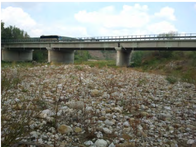
Fig. 48 - Ponte autostradale (A1), visto da monte.
