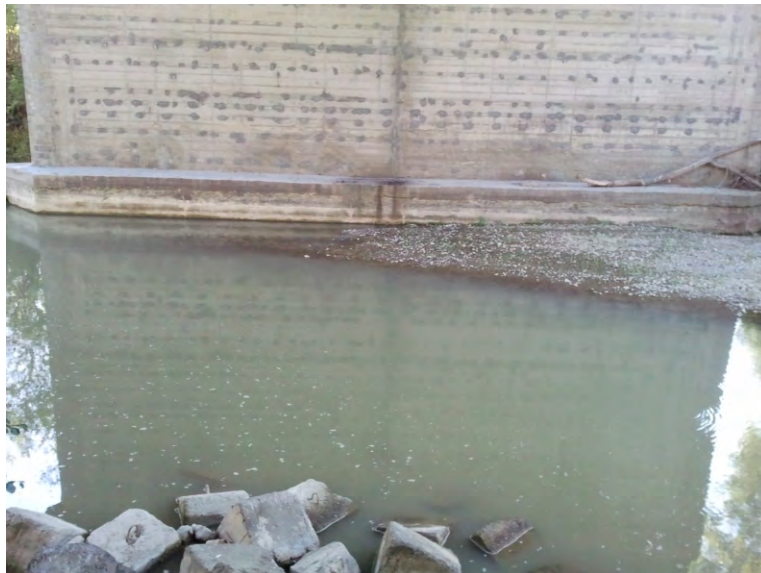
Fig. 71 - Ponte autostradale (A1 - OT8). Foto del pilone destro. In basso i blocchi di calcestruzzo gettati a protezione del pilone sinistro.
