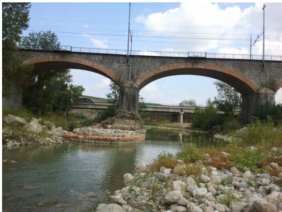
Fig. 47 - Ponte della linea ferroviaria Roma-Firenze, visto da monte.
