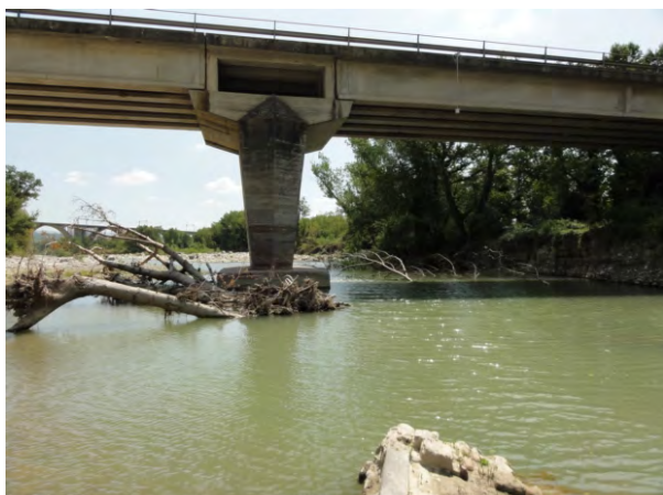
Fig. 43 - Pione nel canale di magra - ponte della provinciale n. 48 visto, da monte.
