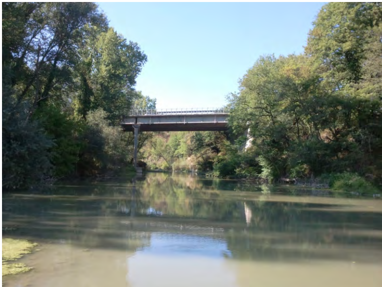
Fig. 70 - Ponte autostradale OT8 (A1). Il punto di vista è da valle.
