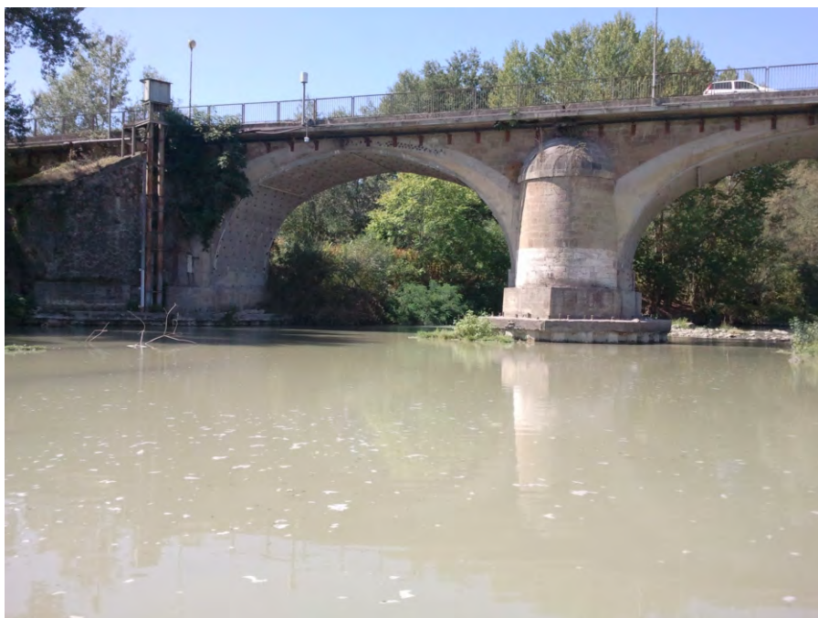
Fig. 68 - Ponte Adunata (statale SS71 - OT6). Foto scattata da valle. Si vede il pilone centrale e la spalla destra.
